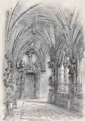
No. 38.—Cloister of Cadouin.
